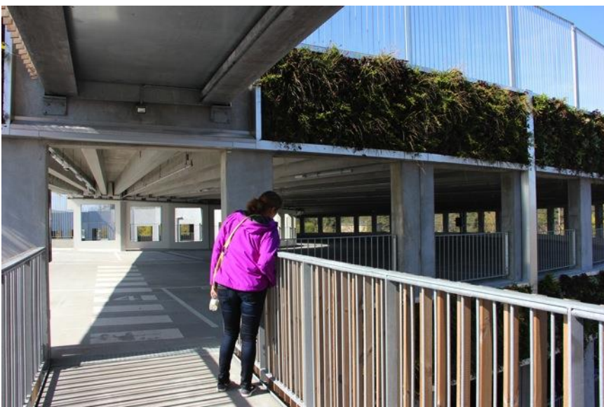
Parkeringshusets åbne konstruktion gør at der er naturlig ventilation og minimal installeret belysning i parkeringshuset.
