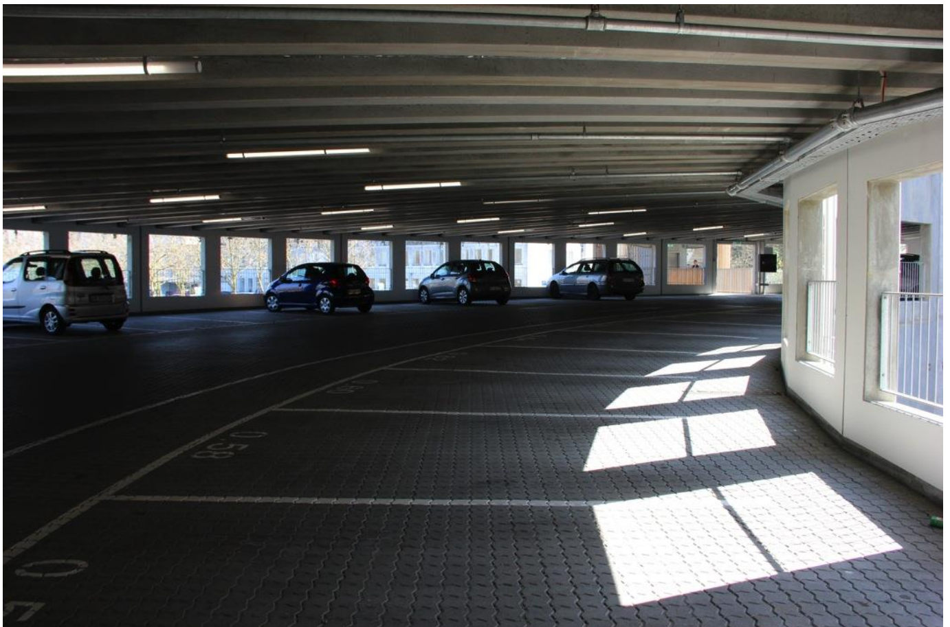
Parkeringshuset er 16 meter højt, har en diameter på 58 meter og har 483 parkeringspladser.
